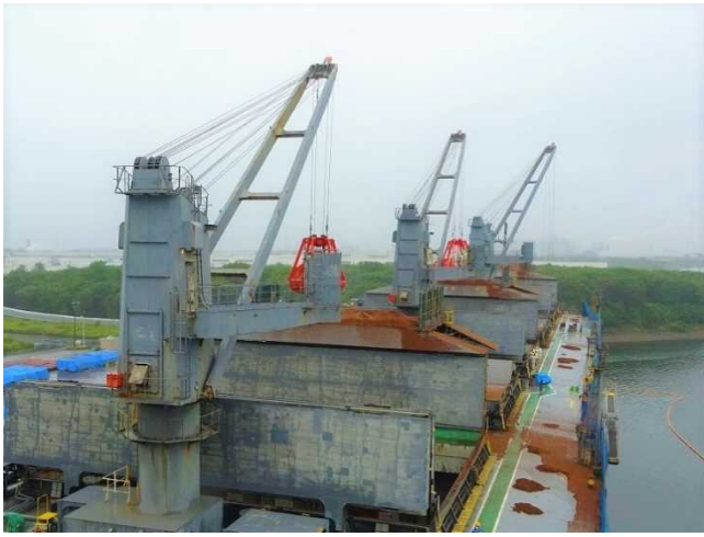
クレーン部分
